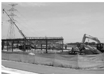
建設工事が進むアンビー熊本
