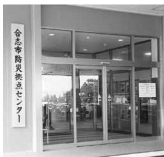
新設した市防災拠点センター
