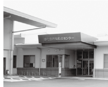
野々島防災拠点センターは4月から稼働
