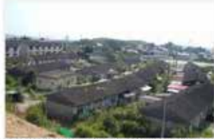
建替前の状況（S30年代に建設された簡易耐火造住宅）
