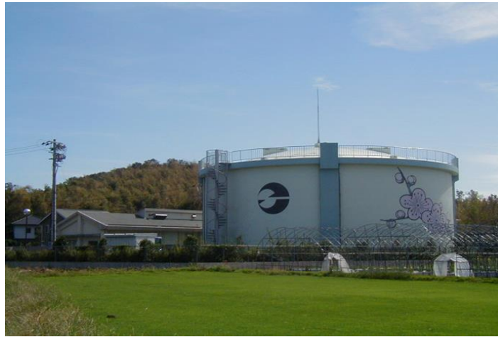
(水道事業：群配水池)
