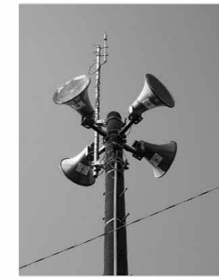
江良区の放送設備
