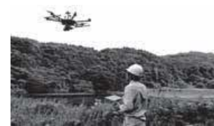
▲ドローン(UAV)による測量
