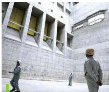
空のごみピット内。ごみが搬入される前の貴重な光景で、黄色の扉からピット内にごみが投入される
