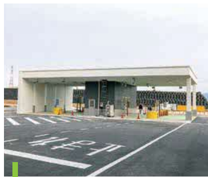
ごみの搬入時に重さを測る計量器。屋根には太陽光パネルも設置されている
