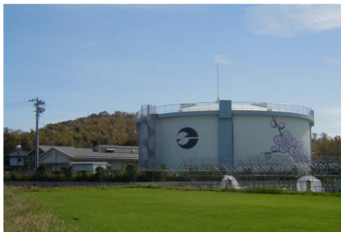
(水道事業：群配水池)
