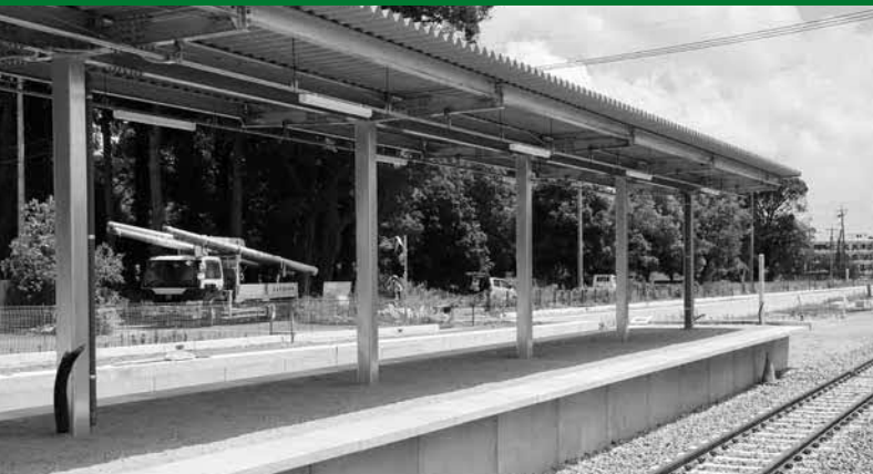
▲新御代志駅の開業に向けて工事が着々と進んでいる
