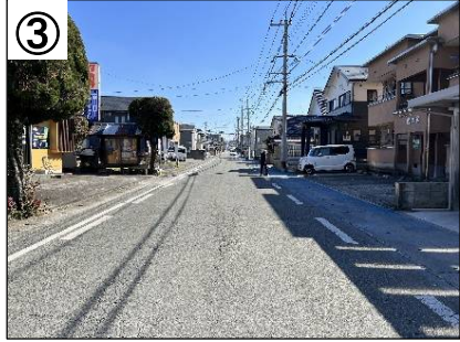
カラー舗装、中央線抹消
