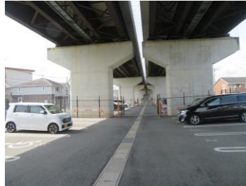
▲ 新須屋駅のP&R駐車場
