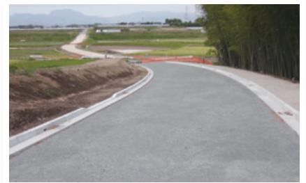
建設中の上群中林線
