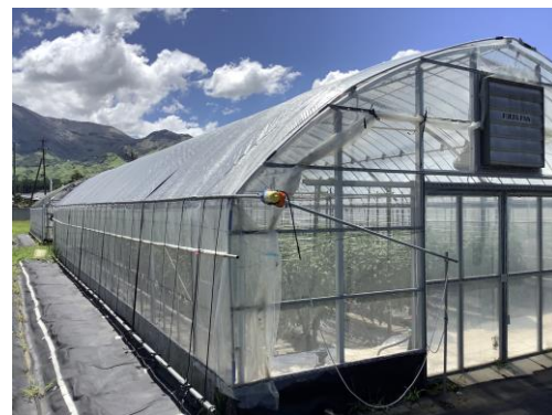
外張りの自動開閉装置
