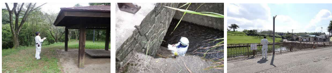
写真 健全度調査の実施
