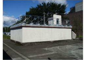
日向第2配水池
