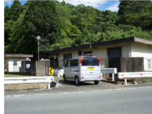
日向第1配水池
