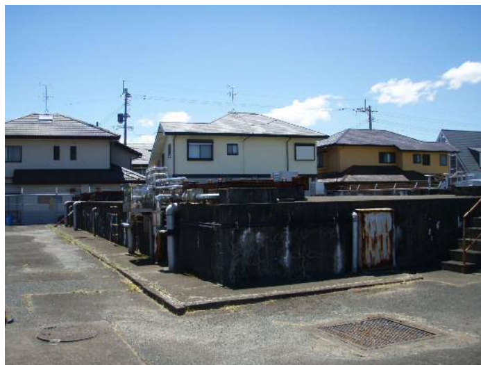
写真 3-3-1 老朽化した新開配水池
