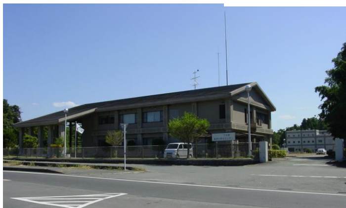
(下水道事業：塩浸川浄化センター)
